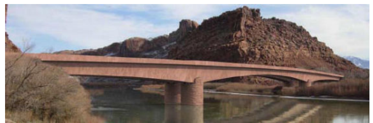
Die neue Brückenkonstruktion
