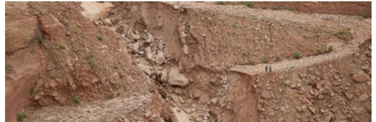
Völlig zerstörte Switchbacks der Mineral Bottom Road Photo: (c) BLM
