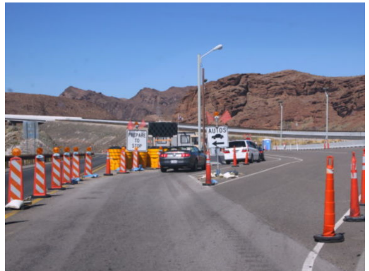
Baustelle kurz vor dem Hoover Dam. Fotoquelle: Stefan Kremer
